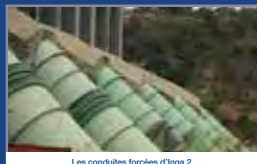
Les conduites forcées d'Inga 2
