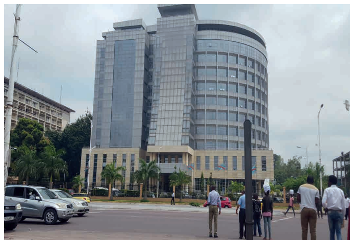
Immeuble intelligent - siège du gouvernement de la RDC
