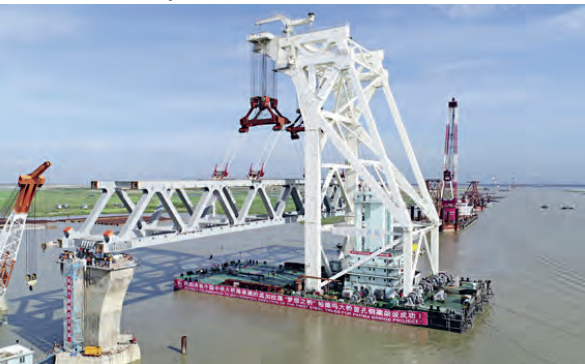
Le pont Padma en construction
