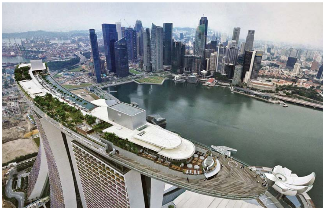
Le parc aérien du Marina Bay Sands compte plus de 10.000 m 2 de terrasses. Six des 19 buildings situés de l'autre côté de la baie ont également des terrasses montées sur plots Buzon.
